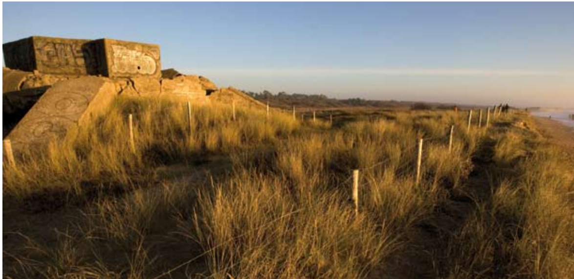
Blockhaus de la plage de Vert-Bois en janvier 2009 et après Xynthia le 28 février 2010.
