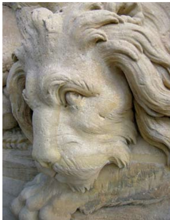
Fronton de la grange photographié depuis l'échafaudage au terme de sa restauration conduite par François Jeanneau, architecte en chef des Monuments historiques.
