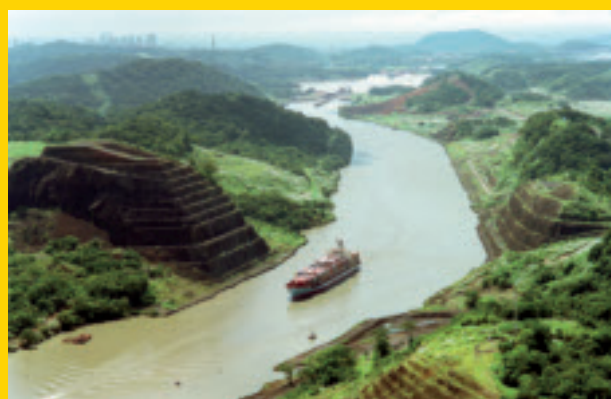
Ecluse de Gatun. Photo Autorité du canal de Panama.
