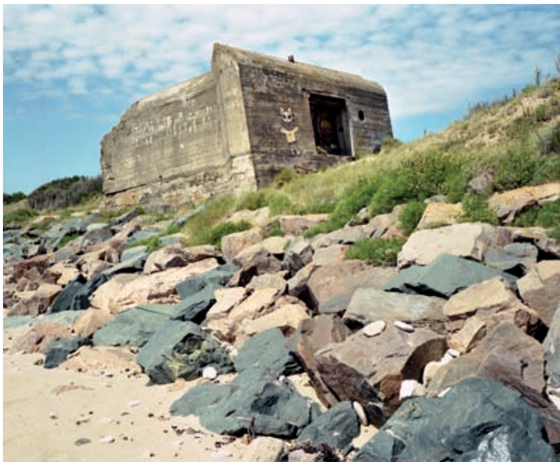
Blockhaus en ruine dans le nord de l'île de Ré.
