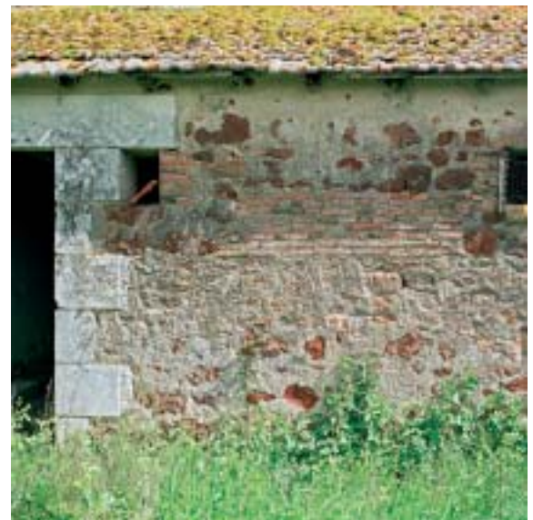
Ci-dessus : l'habitat rural traditionnel reflète la variété du sous-sol régional. Ici, une dépendance à Moulismes (Vienne) où ont été mis en œuvre les matériaux locaux : les calcaires du Jurassique moyen pour l'appareillage de l'ouverture et les grès brun-rouge de l'Eocène (pierre de Moulismes) pour l'élévation du mur.
