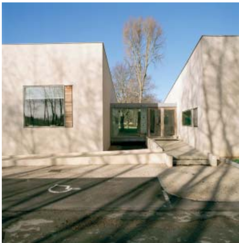
L'entrée du Cure est glissée entre deux bâtiments. Une galerie vitrée relie les trois bâtiments disposés en chapelet. La forme en trapèze de chaque volume accentue les effets de perspective. Les menuiseries en acier brut sont disposées à l'extérieur du mur et les parties ouvrantes sont constituées de petits volets en frêne rétifé.
