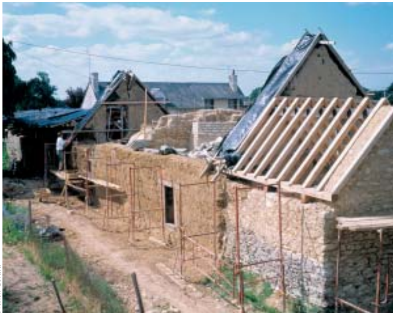
Ferme acadienne en restauration à Archigny.
