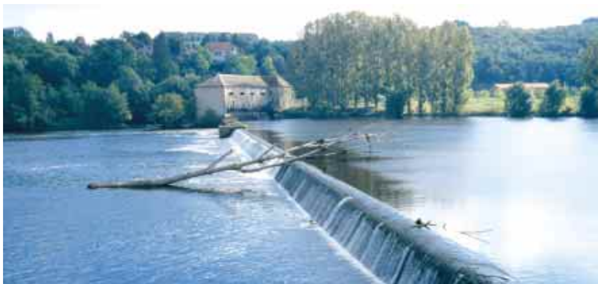
Le barrage sur la Vienne à Bonneuil-Matours, le moulin et sa centrale micro-hydraulique.
