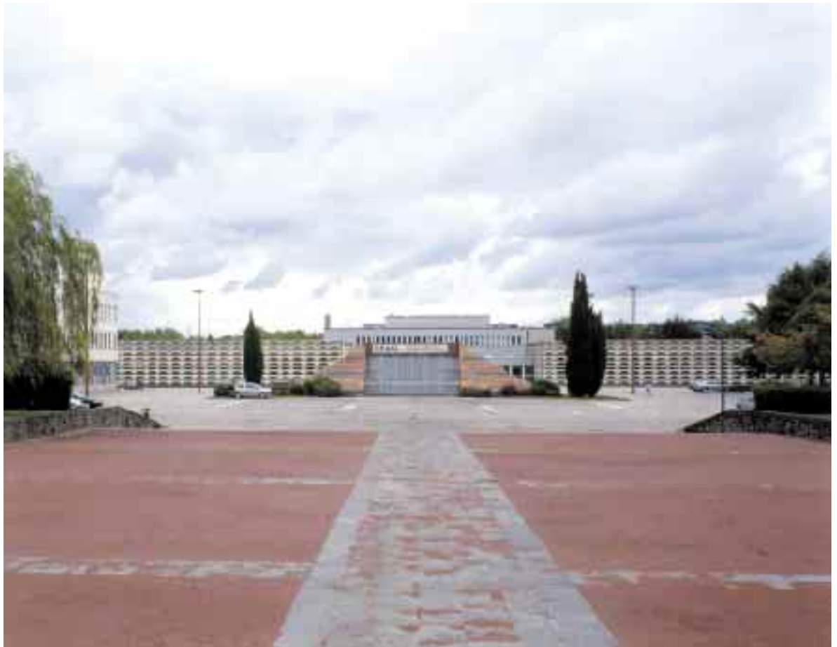
Sur le campus universitaire de Poitiers : la bibliothèque universitaire (ci-contre) et l'Esip, les nouveaux logements étudiants du Crous (page de droite).
