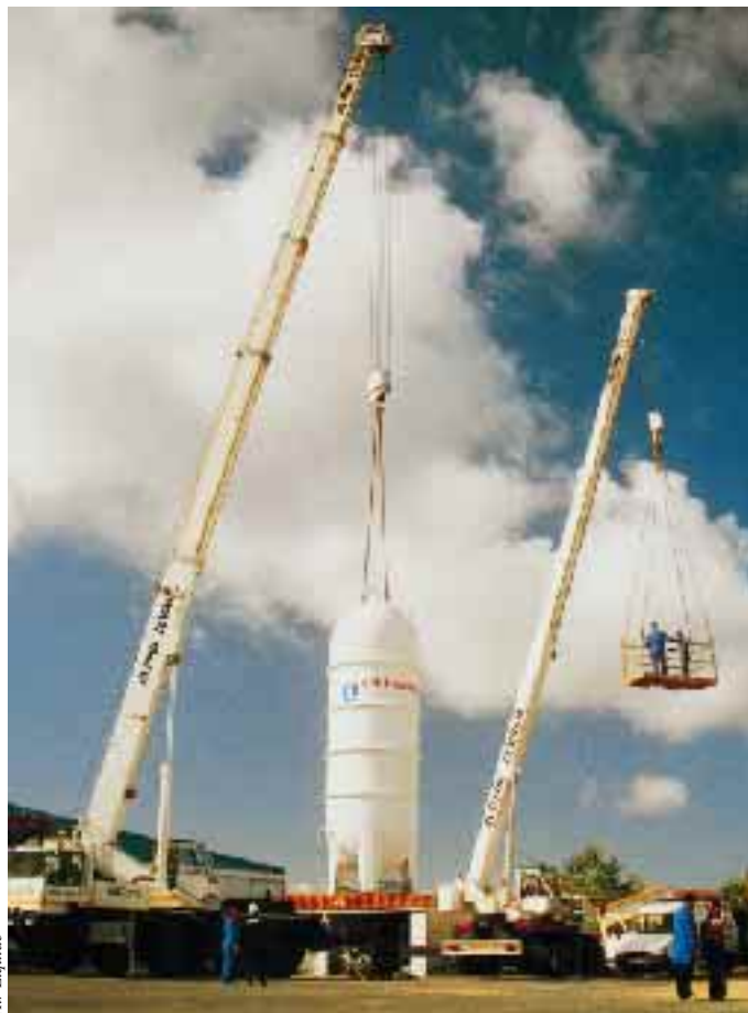
Implantation d'un réservoir de 20 000 l d'azote liquide
