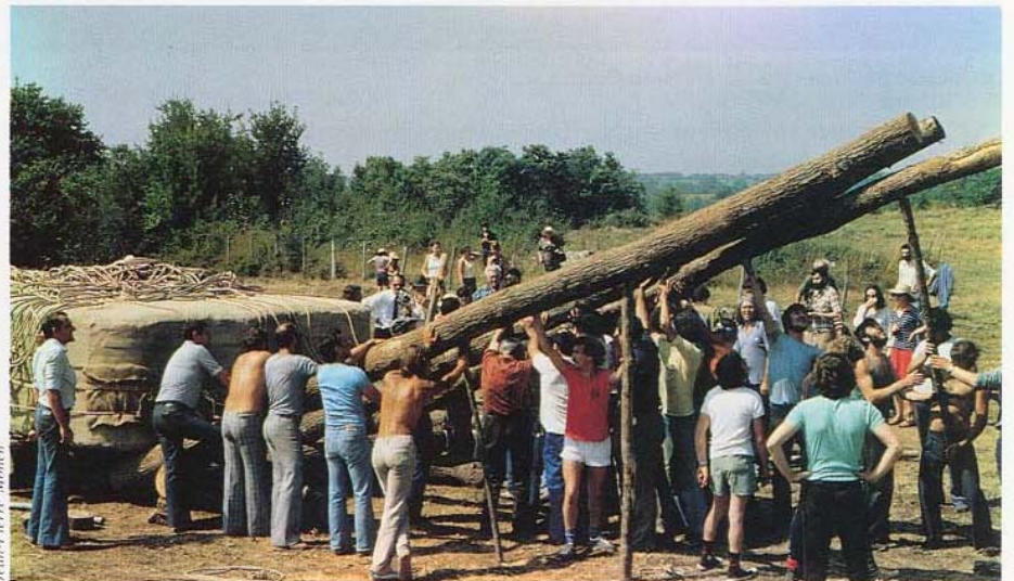
A Bougon en 1979, 200 personnes ont transporté puis levé un bloc de 32 tonnes. Ce bloc de béton était la réplique de la dalle qui couvre la chambre du tumulus F2 (photo de gauche).
